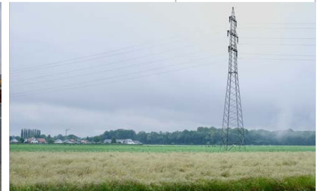
Abbildung 166: Hochspannungsleitung im Leibnitzer Feld, 03.06.2024, 9:10 (rechts)
