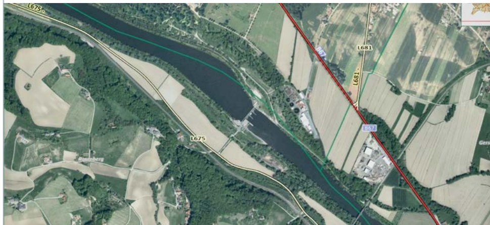
Abbildung 171: Kraftwerk Spielfeld, Luftbild, Quelle: GIS Steiermark, 2024
