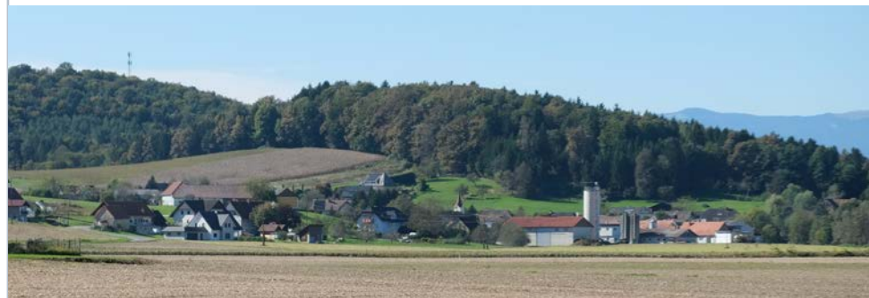
Abbildung 123: Blickrichtung Nordwest, auf Grötsch mit Kirche, Silo, Handymast, 12:16
