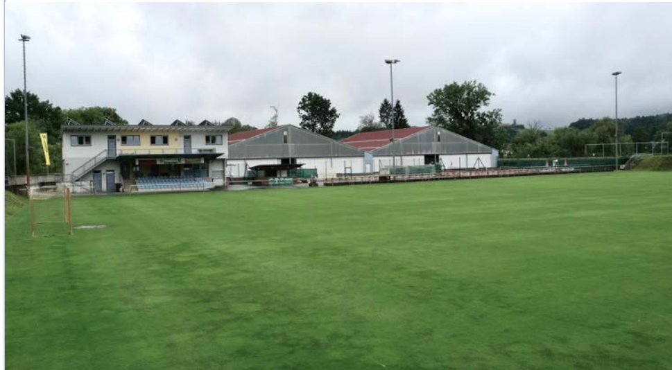
Abbildung 133: Sportplatz und Tennishalle Heimschuh im Sulmtal (oben), südlich im Anschluss an die Sulm, 31.05.2024, 13:18
