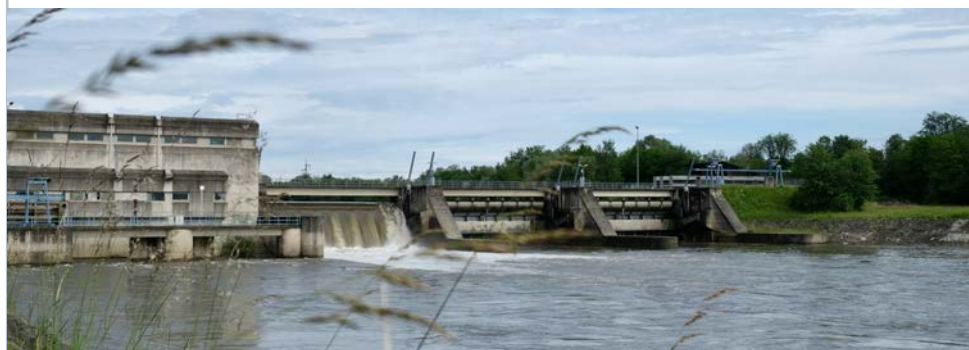
Abbildung 174: Kraftwerk Spielfeld, nach dem Stauwerk, flussabwärts, 02.06.2024, 10:04
